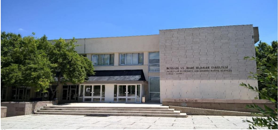
İİBF A Binası Dış Görünümü
