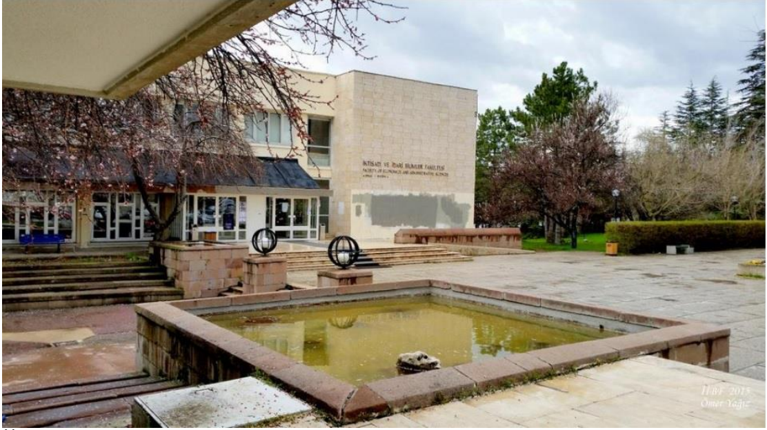
İİBF A Binası Dış Görünümü
