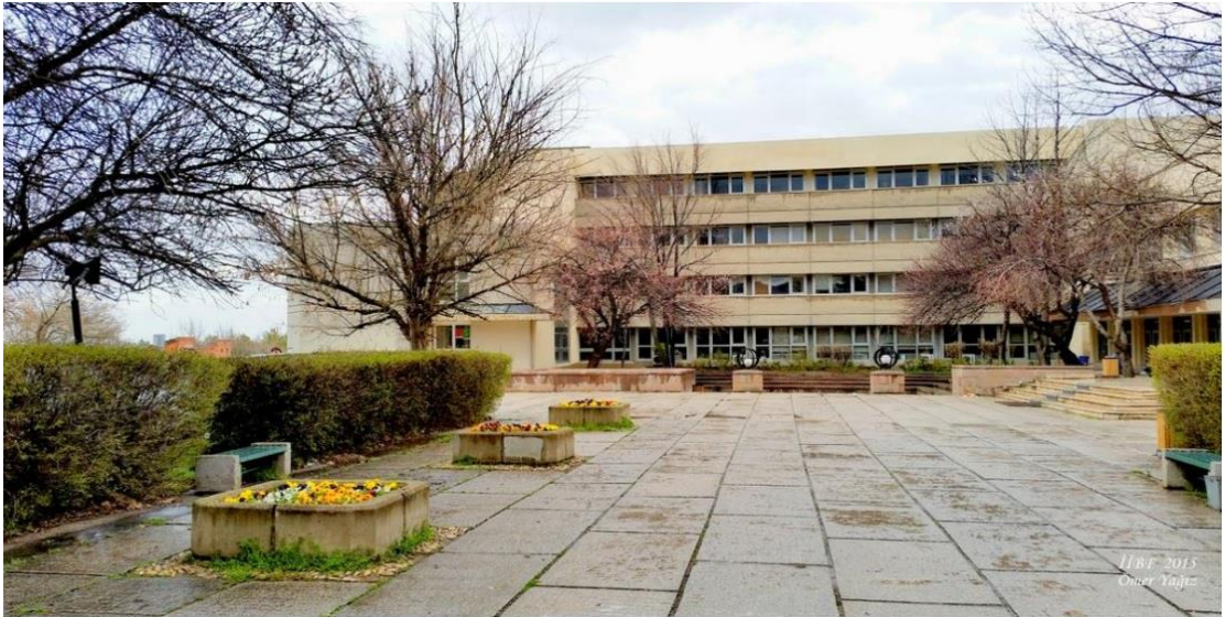
İİBF A Binası Dış Görünümü
